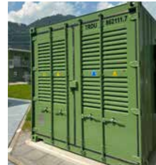
2-flügelige Wartungs- und Zugangstüren vorne mit Zuluftöffnung
