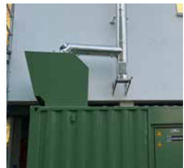
Abluftkanal mit Luftumlenkung seitlich für optimalen Witterungsschutz (demontierbar)
