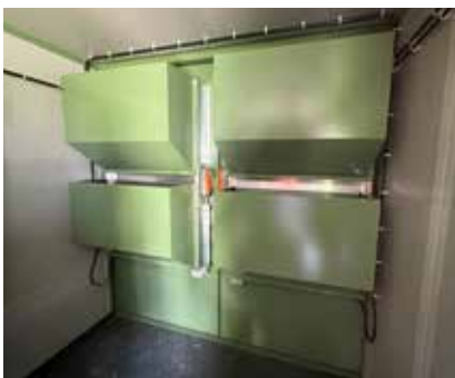
Zuluftöffnungen mit elektrischen Jalousienklappen serienmäßig
