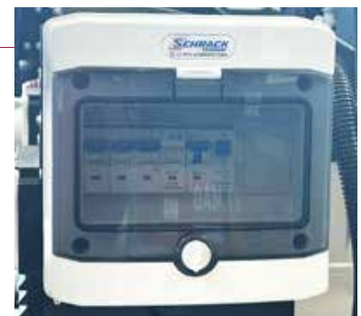
Schalttafelausführung Beispiel nach DGUV 203-032 Ausführung B
