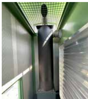
Industrie-Schalldämpfer innenliegend sowie elektrische Abluftklappe serienmäßig
