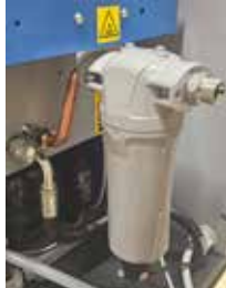
Vorfilter direkt montiert am Kältetrockner (nur bei DF-Version)
