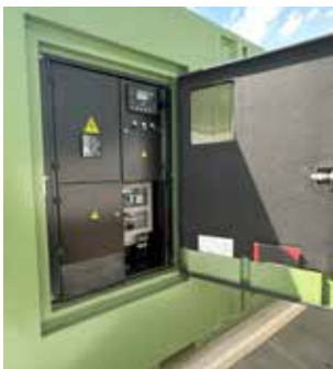
Übersichtliches Bedienfeld hinter versperrbarer Tür mit Sichtfenster
