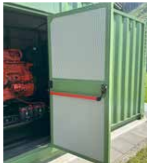
Große Zugangstür auf beiden Längsseiten mit Panikbeschlag
