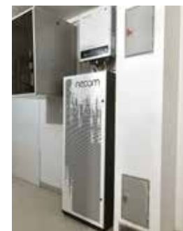
10 kW Hybridwechselrichter mit integrierter Netzersatzumschaltung
