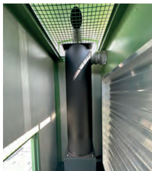
Industrie-Schalldämpfer innenliegend sowie elektrische Abluftklappe serienmäßig
