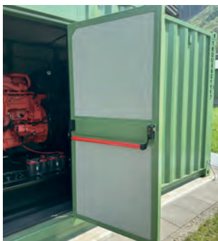
Große Zugangstür auf beiden Längsseiten mit Panikbeschlag
