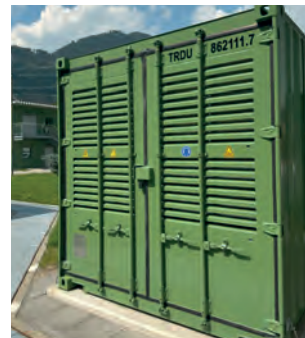
2-flügelige Wartungs- und Zugangstüren vorne mit Zuluftöffnung
