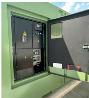
Übersichtliches Bedienfeld hinter versperrbarer Tür mit Sichtfenster
